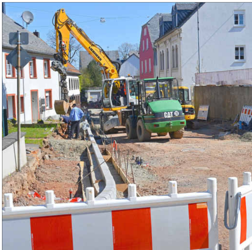
Ausbau Koblenzer Straße: Im Mündungsbereich Alte Kirchstraße werden die Bordsteine gesetzt
